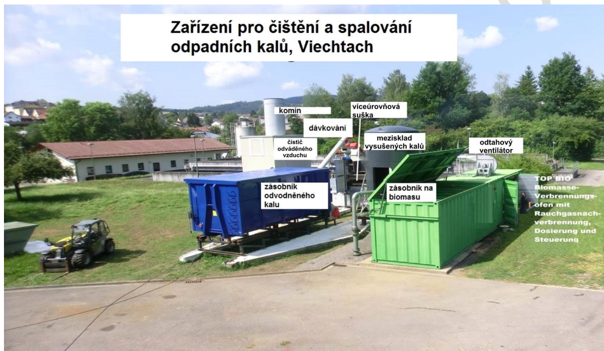
OBRÁZEK 3: ZAŘÍZENÍ PRO SUŠENÍ A SPALOVÁNÍ ODPADNÍCH KALŮ V AREÁLU ČOV (REFERENČNÍ INSTALACE)
